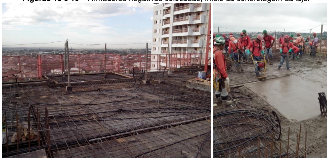
Figuras 18 e 19 – Armaduras negativas colocadas; Início da concretagem da laje.
