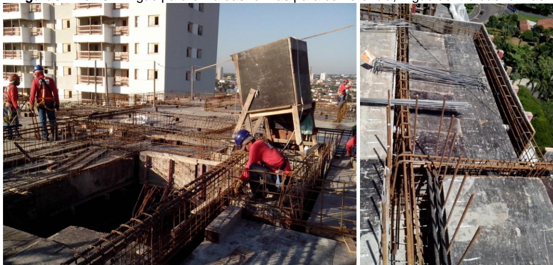
Figuras 14 e 15 – Vigas para cima das formas para conferência; Vigas dentro das formas.
