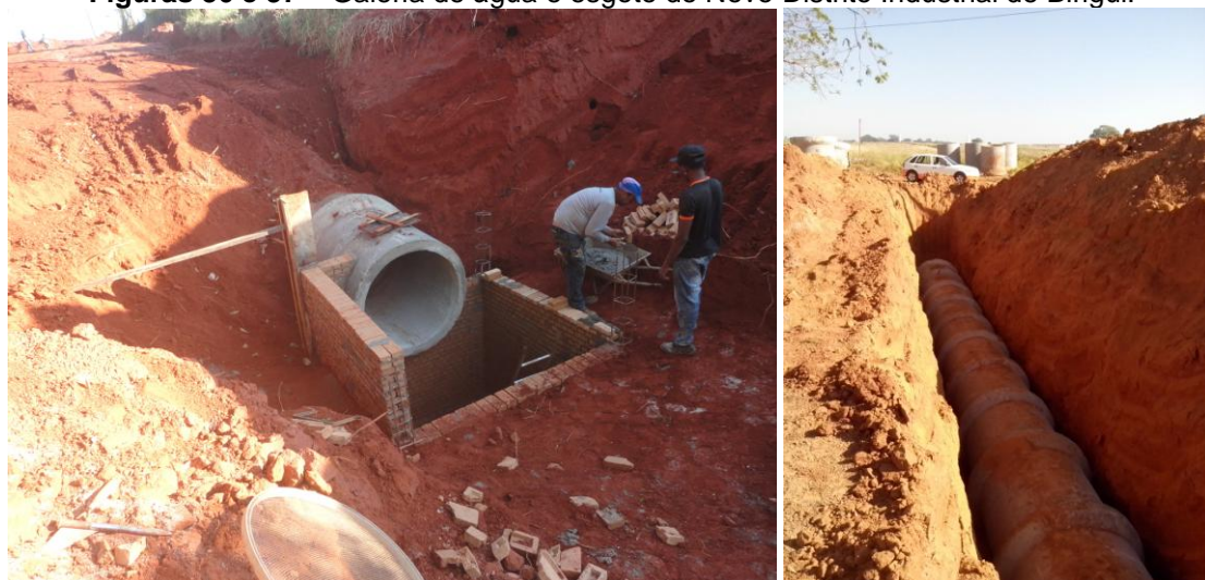
Figuras 36 e 37 – Galeria de água e esgoto do Novo Distrito Industrial de Birigui.
