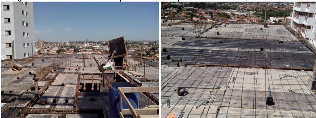
Figuras 16 e 17 – Início da colocação de armaduras positivas; Armaduras positivas colocadas.
