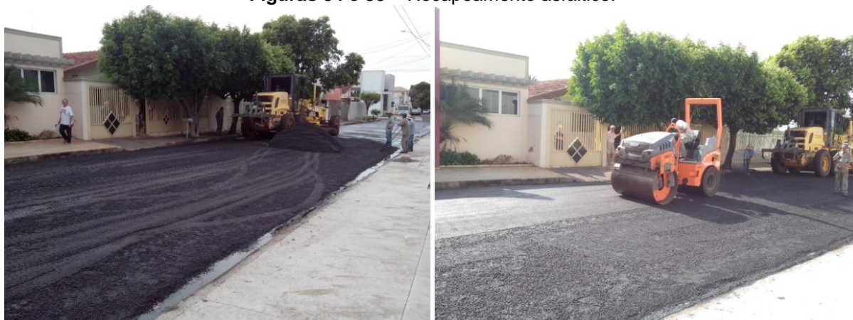
Figuras 34 e 35 – Recapeamento asfáltico.
