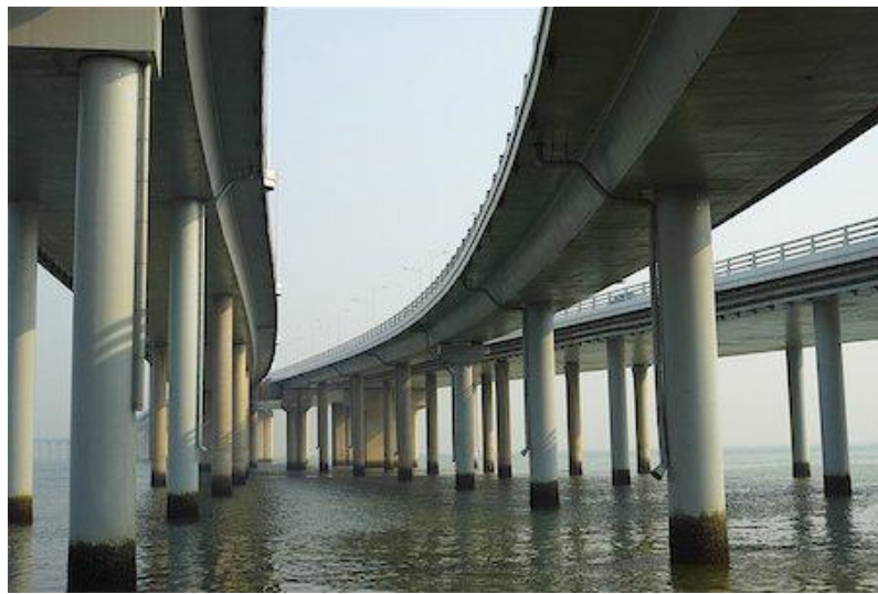
Figura 8 – Estrutura de concreto armado em contato com água marítima segundo Corsini (2013).
