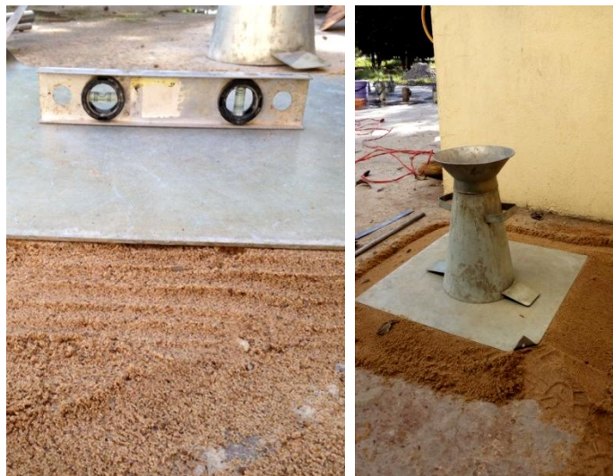
Figura 21– Nivelamento da placa de base.
