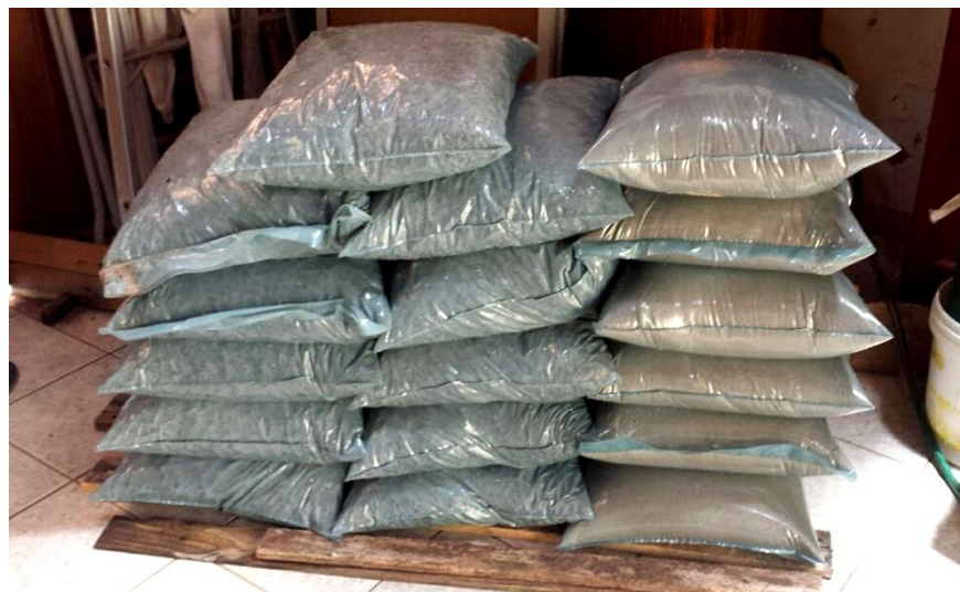
Figura 17 – Materiais ensacados protegidos contra intempéries.
